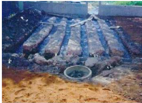
Figura 90 – Valas de infiltração construídas e esquema do leito filtrante
