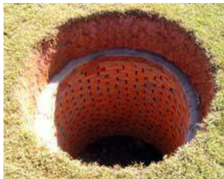
Figura 91 – Tipologia de sumidouro: sumidouro de tijolo
