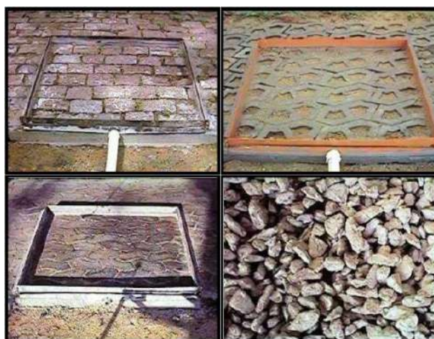
Figura 117 – Exemplos de pavimentos permeáveis
