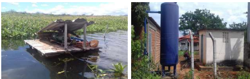
Figura 44 – Local de captação da água e sistema simplificado de tratamento (Filtro de areia)
