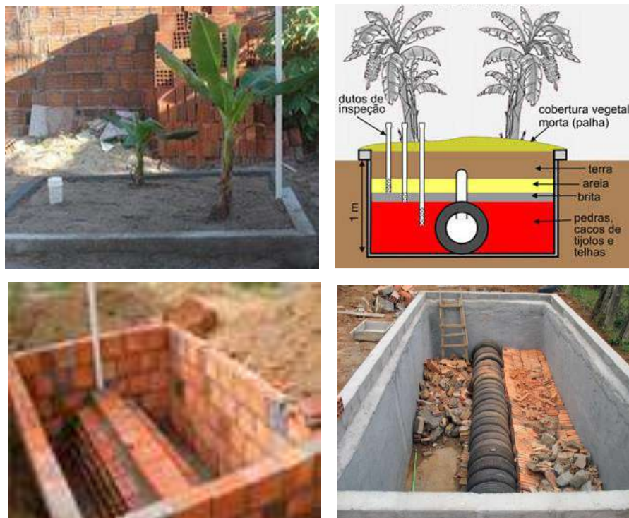
Figura 100 – Tanque de evapotranspiração
