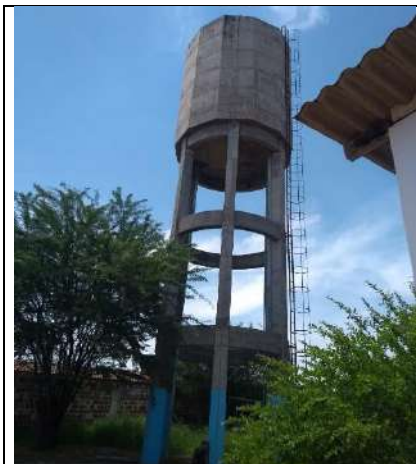
Figura 36 – Reservatório elevado do setor de distribuição da Sede de Anagé.
