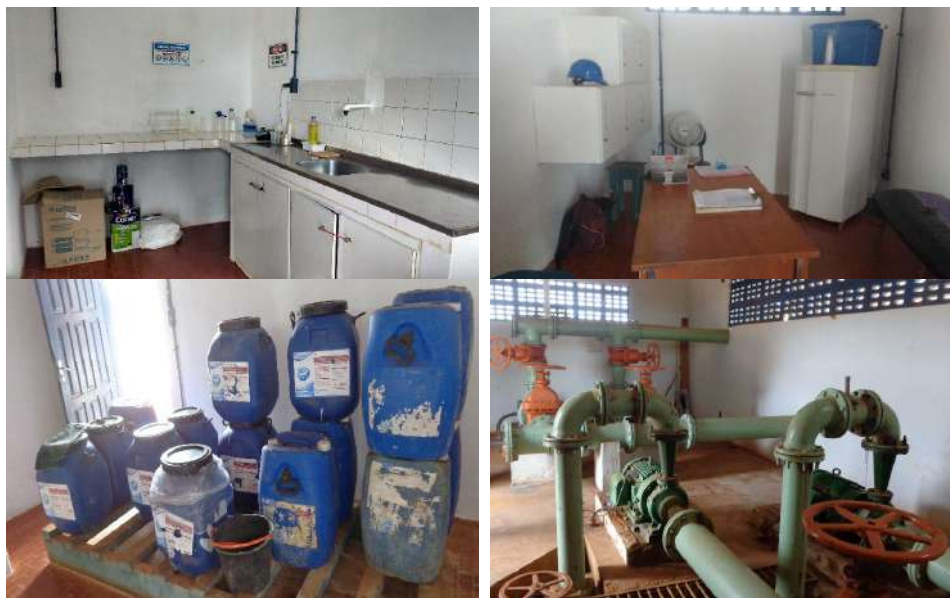
Figura 34 – Estrutura do laboratório do SAA da Embasa, em Anagé
