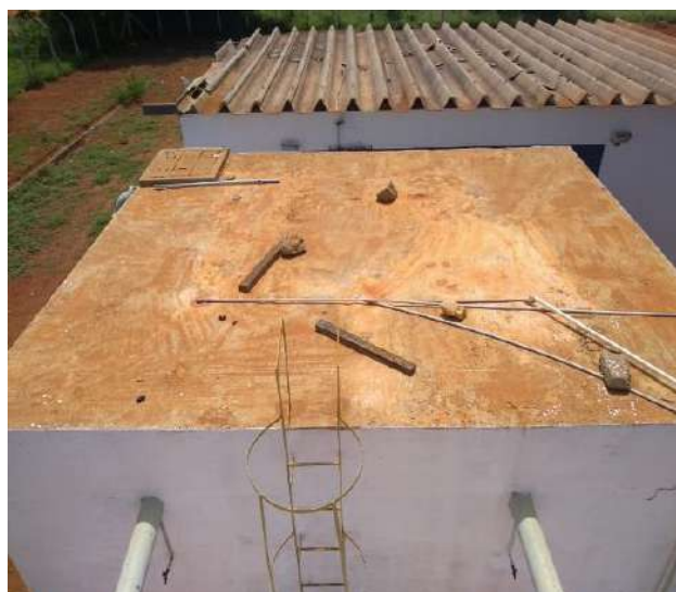
Figura 35 – Estrutura de Reservação do SAA da Embasa.
