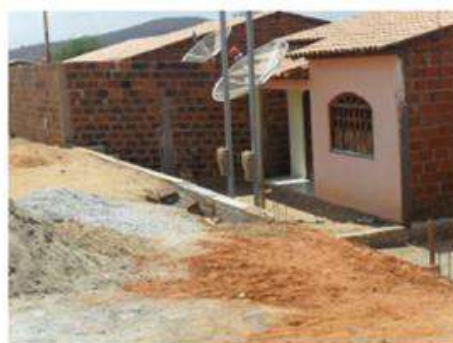
Foto 4: Área de alagamento.
