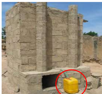
Figura 104 – Bombonas de armazenamento temporário (esquerda) e de estocagem (direita) em sanitário com separação de urina implantadas em países da África
