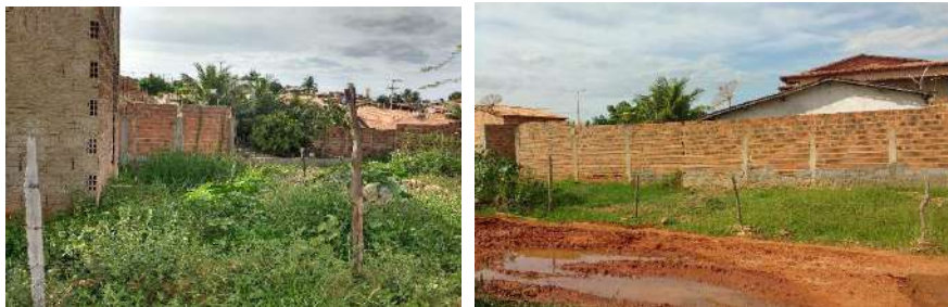
Figura 57 – Passagem da drenagem dentro de lotes urbanos em Anagé
