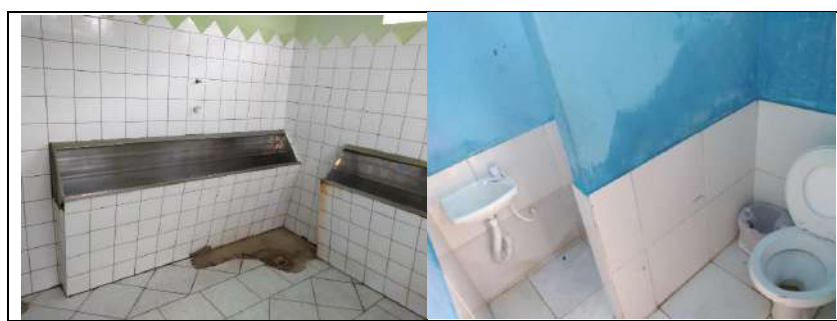
Figura 69 – Banheiro localizado no Mercado Municipal, em Anagé
