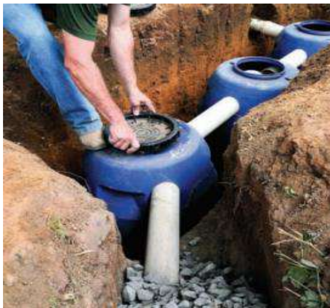
Figura 97 – Instalação das fossas sépticas econômicas
