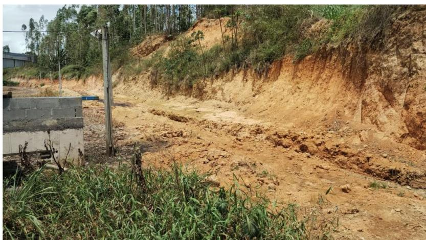
Foto 04: Vala aberta para drenagem de água pluvial.
