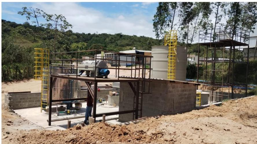
Foto 01: Implantação de sistema primário - flotor.
