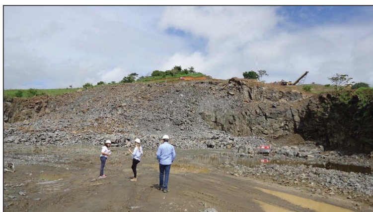
Foto 5. Equipe realizado a inspeção.
