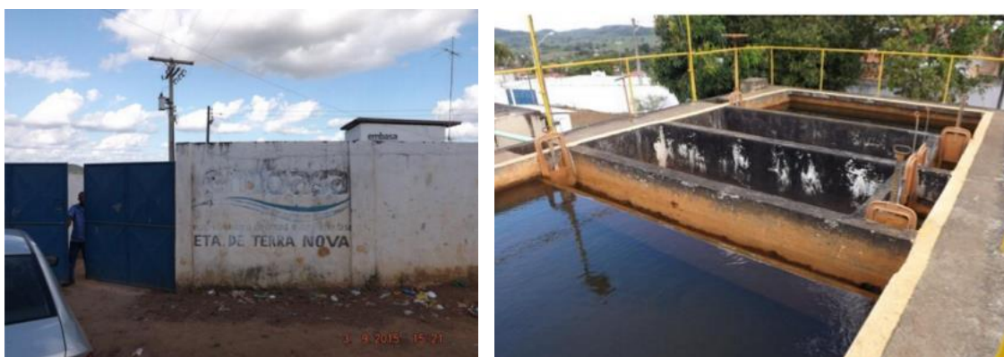
Figura 13 - ETA SAA Terra Nova Bahia - Embasa
