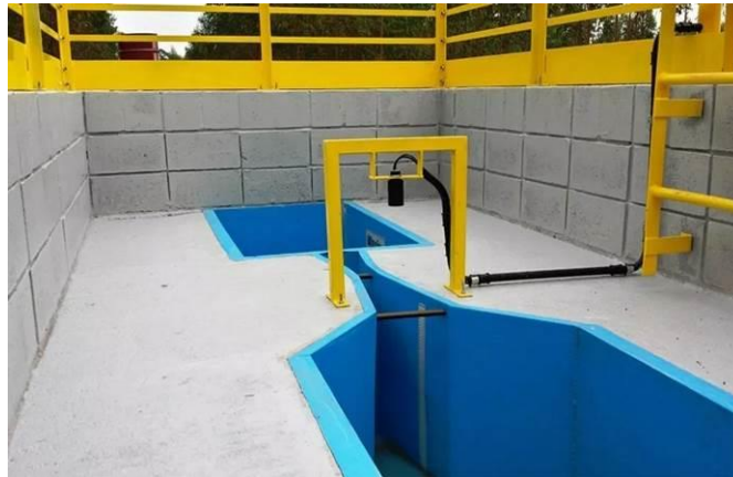
Figura 27 – Calha Parshall
